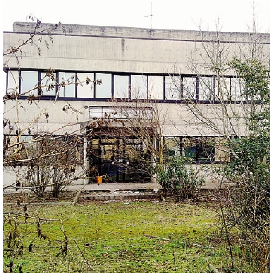
La palazzina uffici dell'ex Schiavi: sull'area un nuovo polo produttivo
