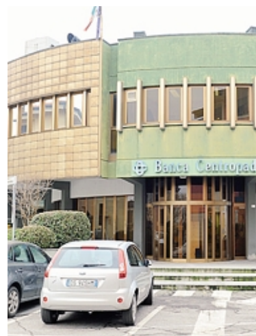
Uffici di Centropadana a Guardamiglio
